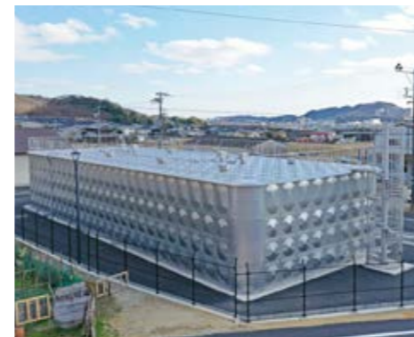
ステンレス製受水槽 船津浄水場からの水道水を貯蔵します。
